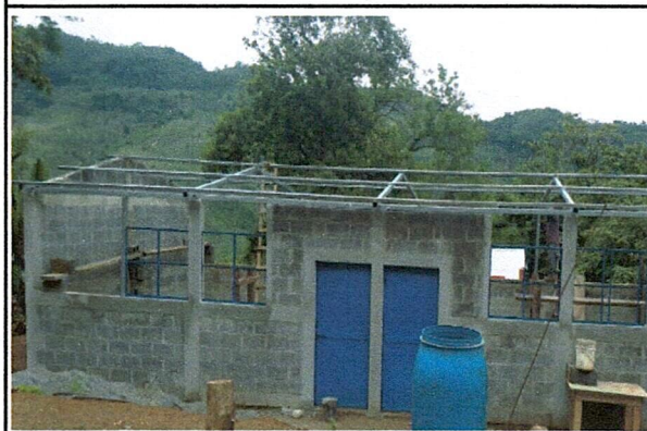
Foto 4: MEJORAMIENTO DE TECHO, ESTRUCTURA METALICA
