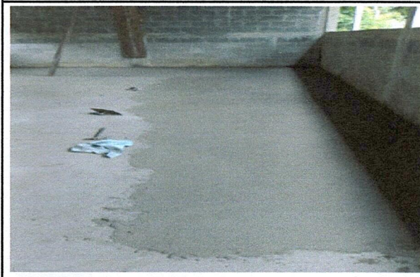
Foto 4: MEJORAMIENTO TORTA DE CEMENTO RUSTICA
