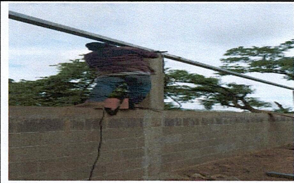
Foto 1: MEJORAMIENTO DE TECHO ESTRUCTURAL
