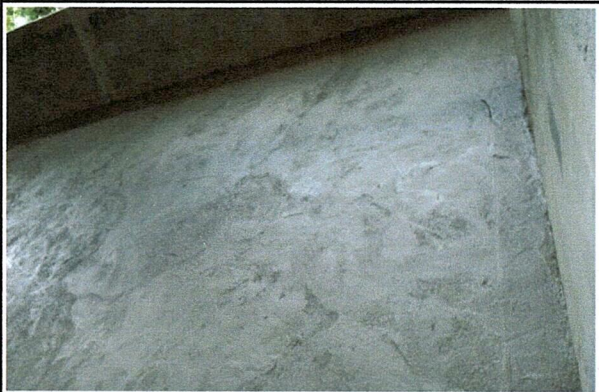
Foto 3: MEJORAMIENTO TORTA DE CEMENTO RUSTICA
