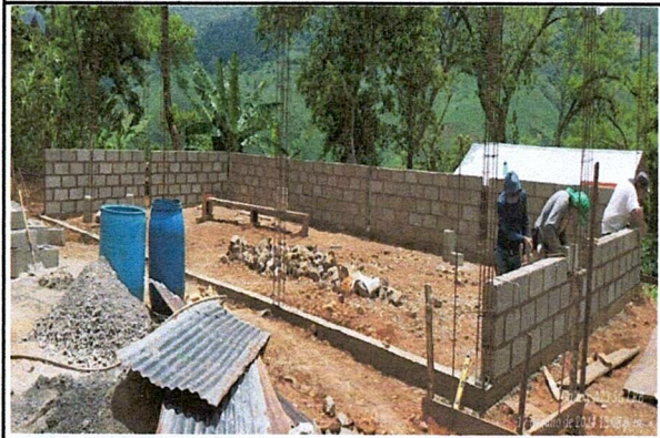
Foto 3: MEJORAMIENTO DE PAREDES DE MODULOS
