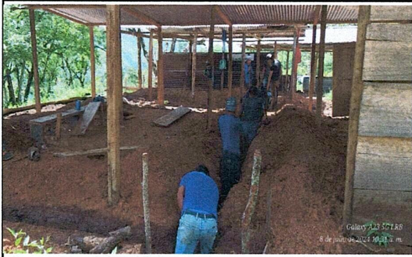
Foto 1: MEJORAMIENTO DE PAREDES DE MODULOS
