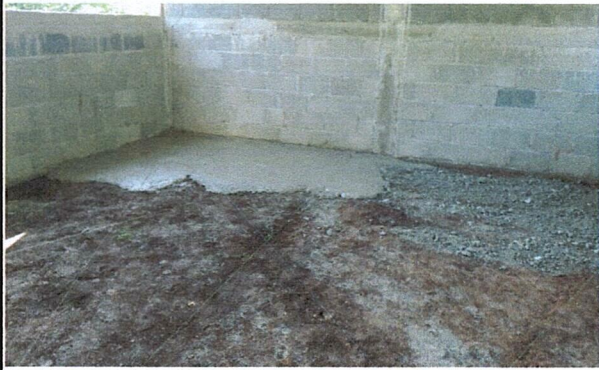
Foto 1: MEJORAMIENTO TORTA DE CEMENTO RUSTICA
