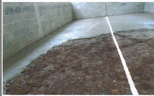
Foto 2: MEJORAMIENTO TORTA DE CEMENTO RUSTICA
