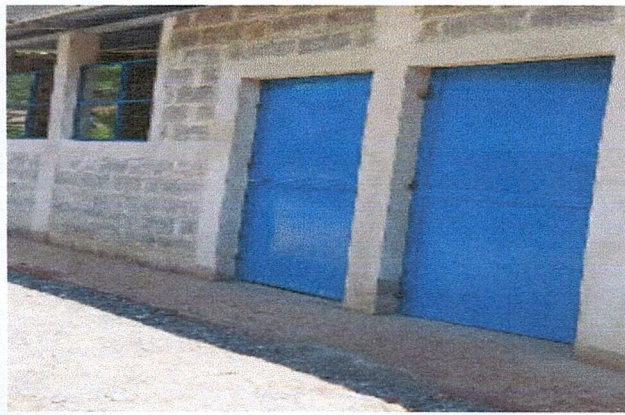
Foto 3: MEJORAMIENTO DE PUERTAS Y VENTANAS
