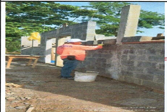
Foto 4: MEJORAMIENTO DE PAREDES DE MODULOS
